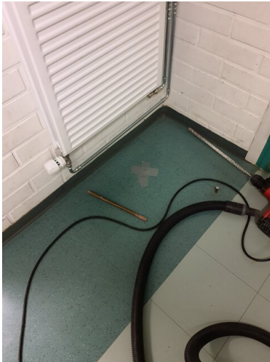
Mittapisteeet porattu ,puhdistettu tulpattu, tiivistetty 28.9.2023.
