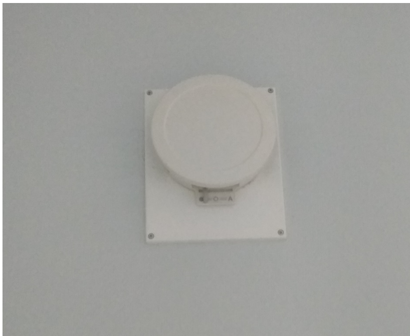
Kuva 23-Uudempi ilmanvaihtojärjestelmän venttiili
