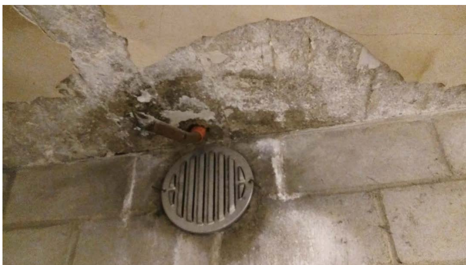
Kuva 19-Käyttämättömän liiketilan kellarin ilmastointikanava
