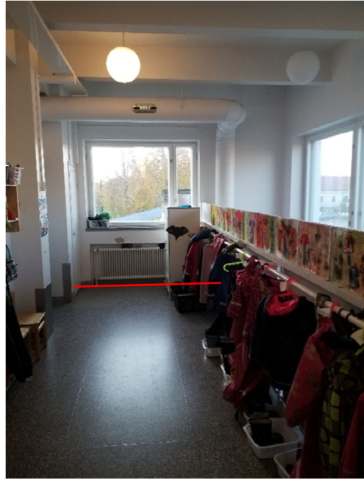
Kuva 6. A-osan toisessa kerroksessa todettiin merkittävää ilmavuotoa matalan osan yläpohjasta rakenteiden liittymän kohdalta.
