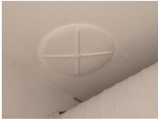
Kuvat 2. Vanhan painovoimaisen venttiilin kierrettävät lautaset oli tiivistetty kittaamalla reunoista.
