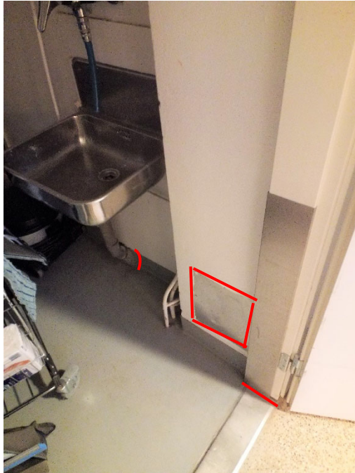
Kuva 5. Siivouskammerossa ilmavuotoa yläpohjasta todettiin viemärin läpiviennistä ja viemärin kotelosta sekä kynnyksen karmin alaosasta.
