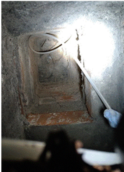
Kuva 7. Vanhan painovoimaisen venttiilin kitauksen pitävyyttä testattiin laskemalla yläpohjatilaa palopermannolta merkkiainetta suoraan wc-tilan venttiin päälle.
