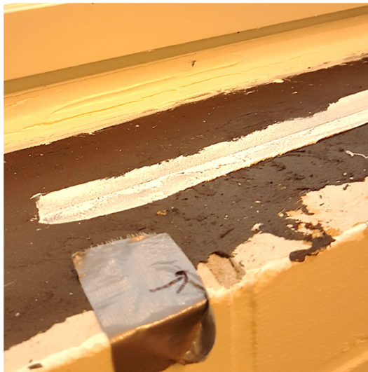
Kuvat 6–7. Ilmavuotoja tiivistetyssä sisäkuorirakenteessa.
