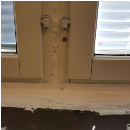
Kuvat 3–4. Ikkunalaudan alta höyrnsulun liittymät tiivistetty tiivistys massoilla ja ikkunoiden liittymät tiivistetty kittamalla.
