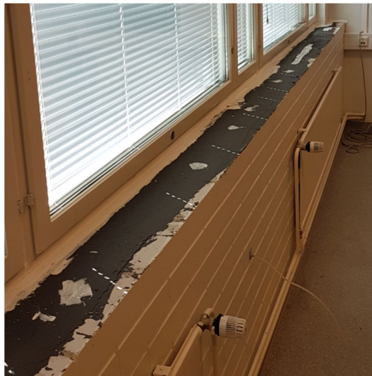
Kuvat 3–4. Ikkunalaudan alta höyrnsulun liittymät tiivistetty tiivistys massoilla ja ikkunoiden liittymät tiivistetty kittamalla.
