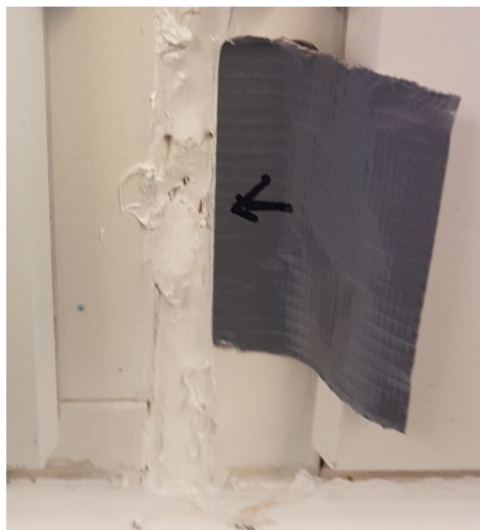
Kuvat 8–9. Ilmavuotoja ikkunarakenteissa.
