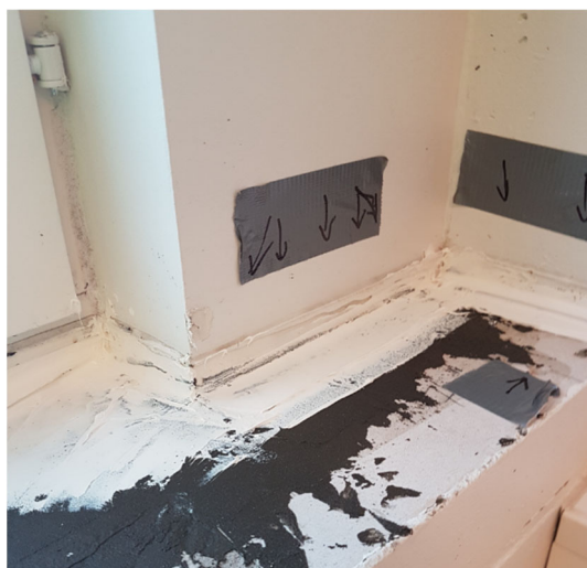
Kuvat 10–11. Ilmavuotoja pilarin ja sisäkuoren liittymässä
