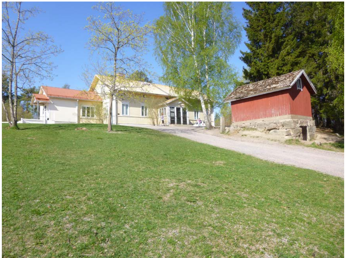
Näkymä vanhalta koulumäeltä – vasemmalla koulurakennus laajennuksineen ja oikealla kellarivaja.
