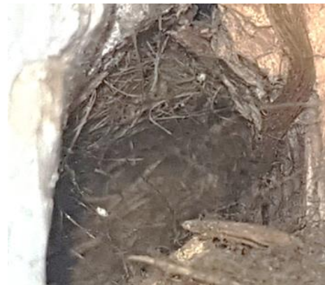
Kuva 22. Ikkunoiden tilkevälisteriteenä on pellavarivettä.
