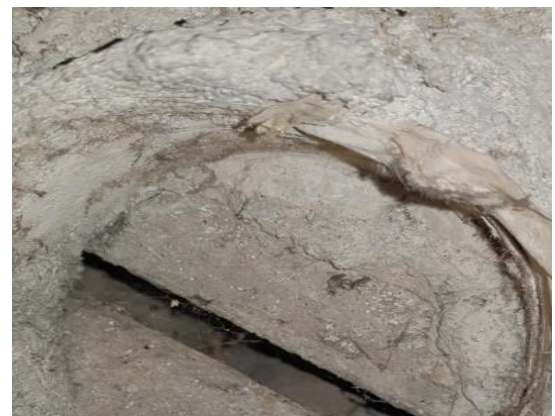
Kuva 11. Palopermannon alla on muottilautaa.
