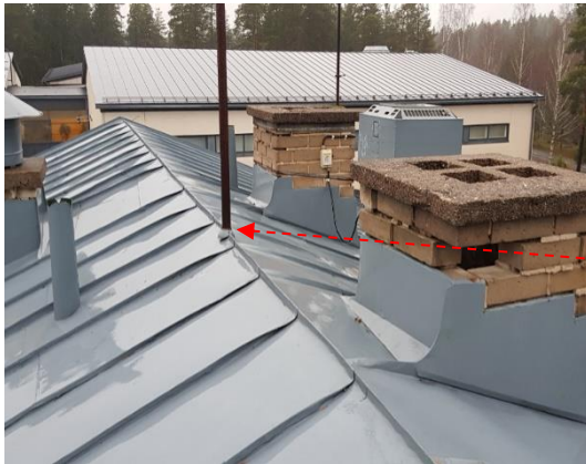
Kuvat 6 ja 7. Katon läpiviennin tiivistys on puutteellinen.
