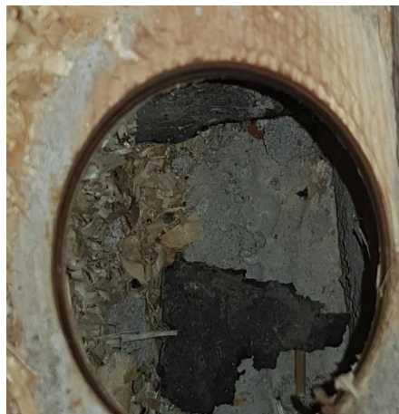
Kuva 38. Raakalautaan on porattu rasiaterällä reikä. Raakalaudan alapuolella on toinen eristetila, jossa on purueristettä, kaarnaa ja puurakenteita.
