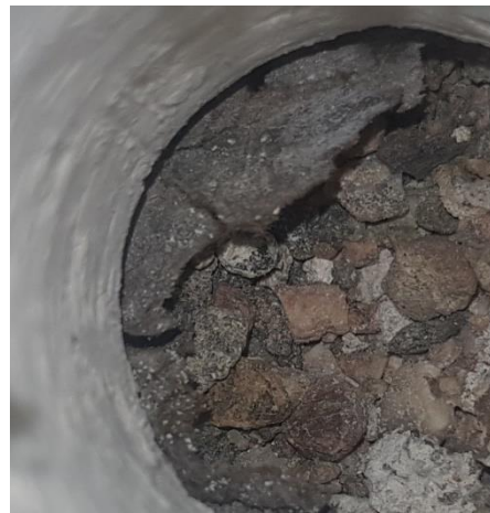
Kuvat 35 ja 36. Pintalaatan alla on irrotuskerros, jossa on tervapaperia, pahvia ja soraa.
