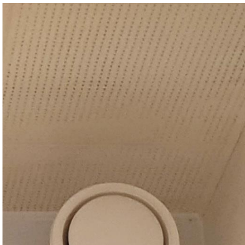
Kuva 46. Sisäkatossa olevat äänenvaimenninlevyt ovat puukuitulevyjä.
