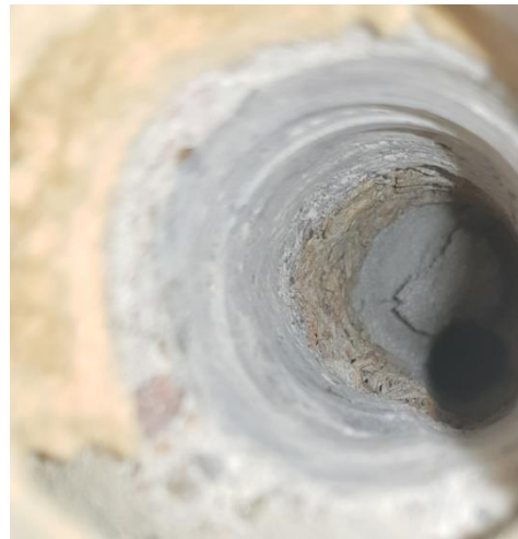
Kuva 13. Yläpohjassa on betonilaatan yläpuolella lastuvillalevyä ja kaasubetonia.
