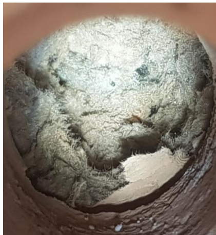
Kuva 14. Ulkoseinän lämmöneristeenä on paperipintaista mineraalivillaa.
