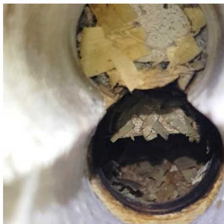
Kuva 39. Kuvassa näkyy betonipalkin reuna, pintalautaa, muottilautaa sekä purueristettä.
