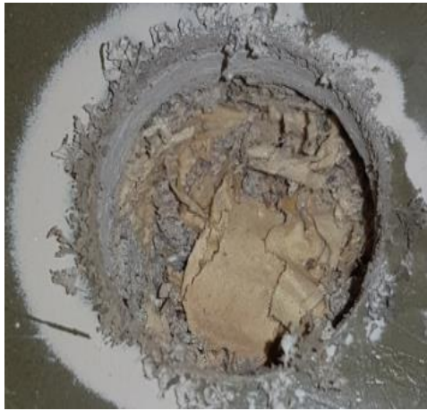
Kuvat 35 ja 36. Pintalaatan alla on irrotuskerros, jossa on tervapaperia, pahvia ja soraa.
