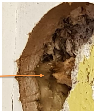
Kuva 34. Pilarin takana on mineraalivillaeristettä.
