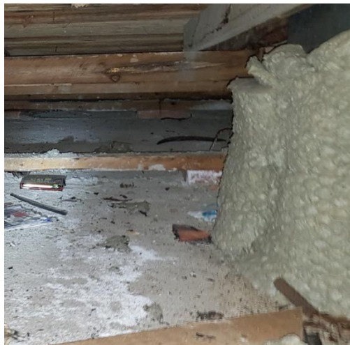
Kuva 12. Yleiskuva opetussiiven yläpohjasta.
